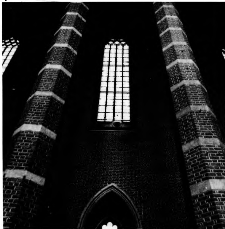
Ryc. 8. Kościół św. Jakuba w Nysie, szóste przęsło, widok na ścianę północną. (Fot. J. Jarzewicz)
